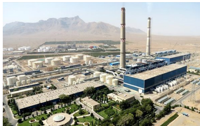
شکل ۲. نمایی از دودکش‌های نیروگاه شهید منتظری اصفهان Fig. 2. An upper view of the Montazeri Power Plant
