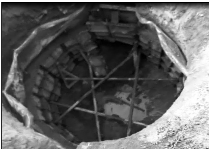
شکل ۷- مراحل ابتدایی بتن ریزی هاضم
