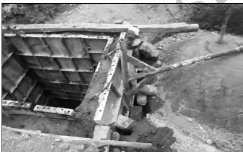
شکل ۸- مراحل آخر بتن ریزی هاضم
